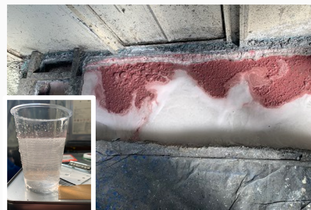
塗料カスは浮上し、循環水は透明である
