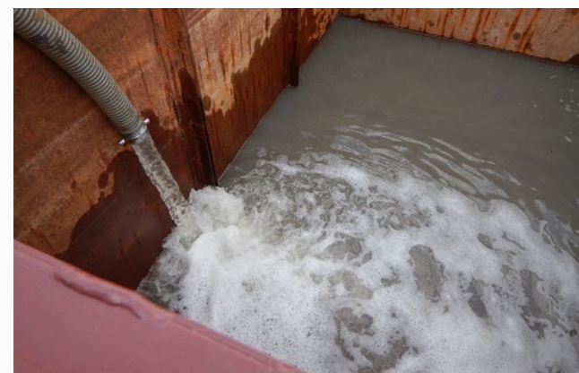
上澄みを仮設タンクへ溜め、清掃後再利用
